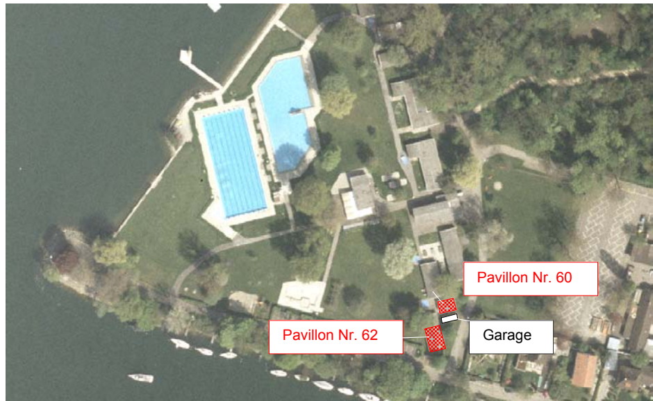
Abbildung 3: Luftbild Strandbad Nidau
